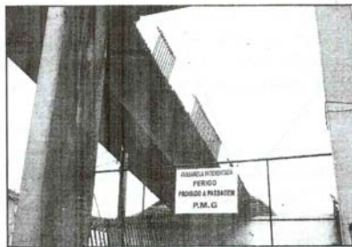
Prefeitura interditou a passarela por falta de condições
