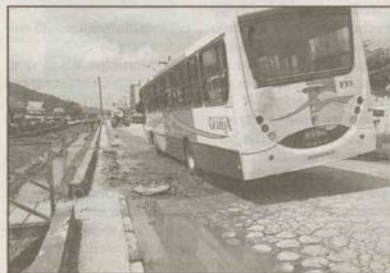
Buracos e alagamentos fazem parte da rotina da via
